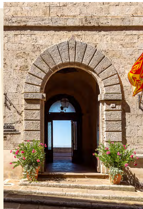
Eingangsportal des Palazzo Ricci in Montepulciano
